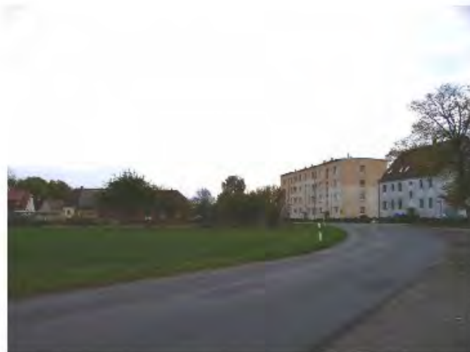
Ballin – Ortseingang / Wohnblocksanierung
