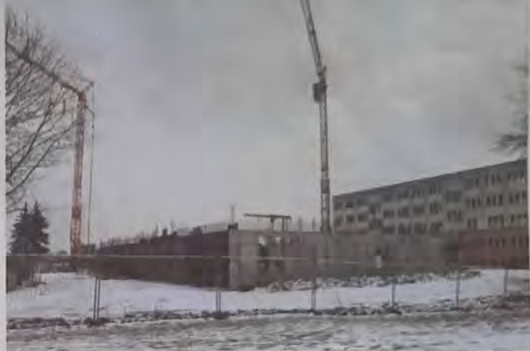
Die Baustelle der Europaschule in Hagenow: Im kommenden Jahr soll hier zügig weitergebaut werden.
